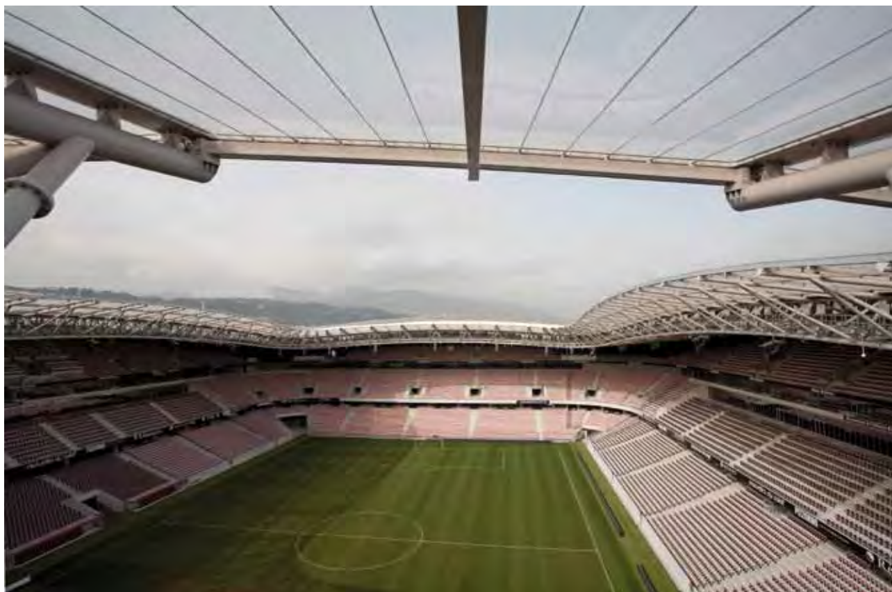
Новаторский фасад и внутреннее кольцо из ETFE.
